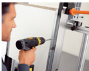
Části zásuvky na závěr sešroubujte. Náročné a namáhavé zafixování odpadá.
